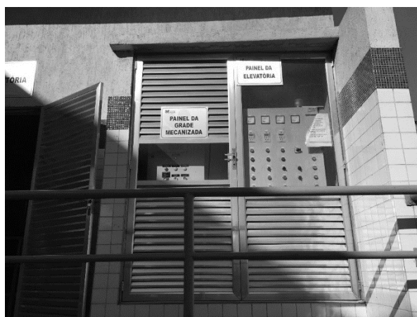
(2) Painel das bombas e grade mecanizada
