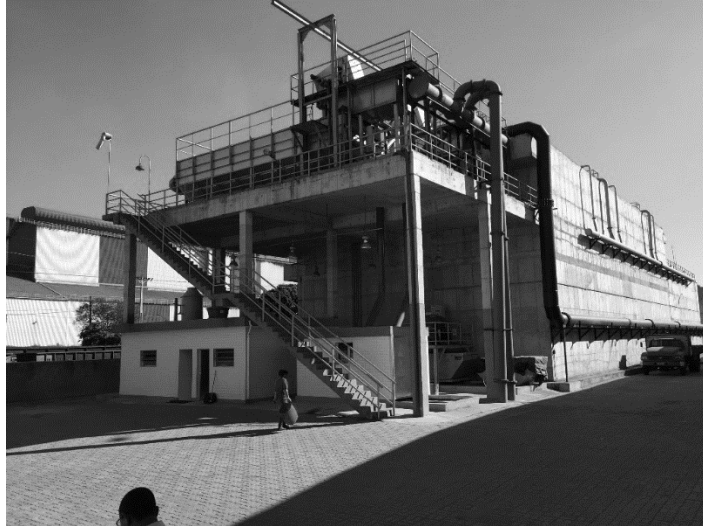
(3) Tubulações por onde entra o esgoto bruto
