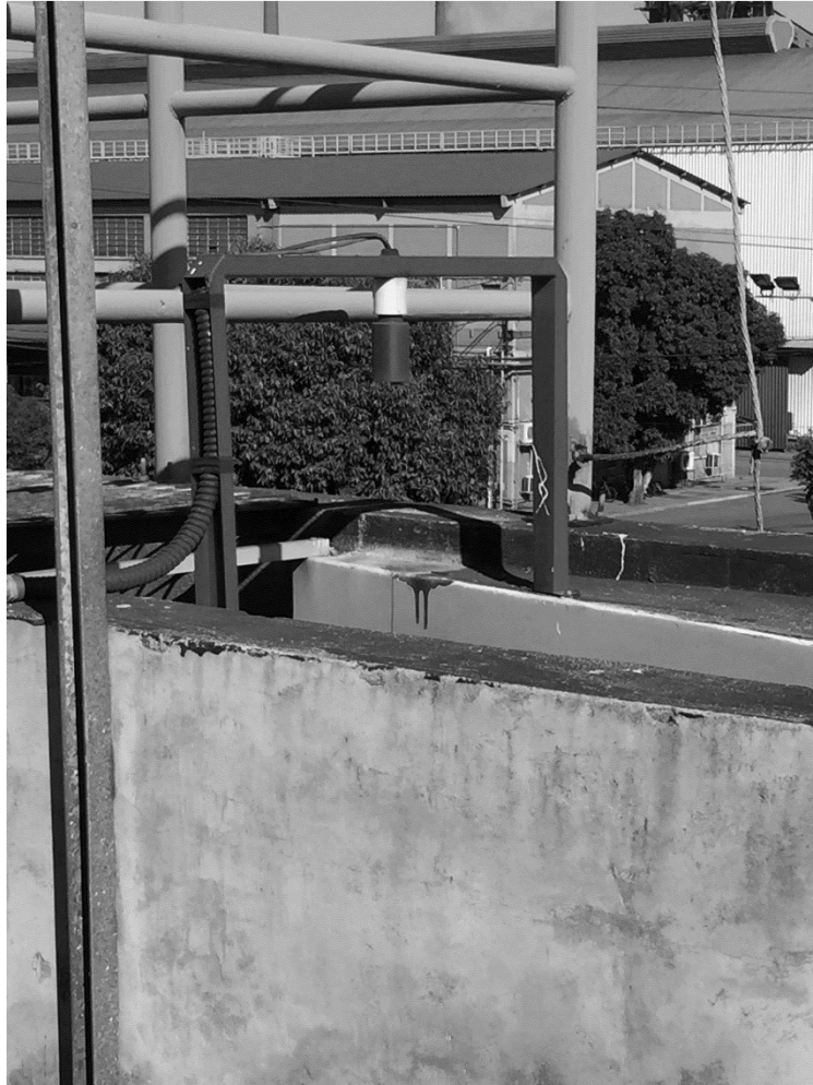
(6) Medidor de vazão na calha parshall
