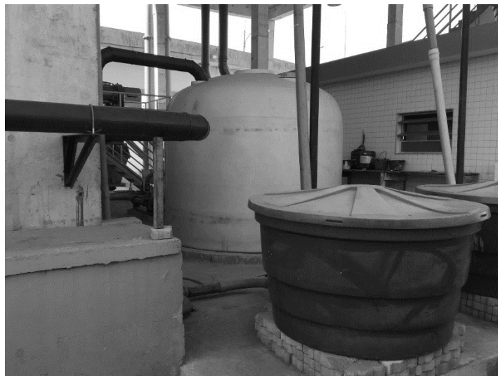
(10) Tanque da Caixa de Gordura
