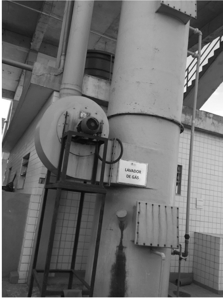
(11) Lavador de Gás
